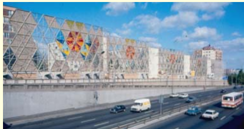
Tường chống ồn màu sắc bằng vật liệu giảm âm (Paris)
