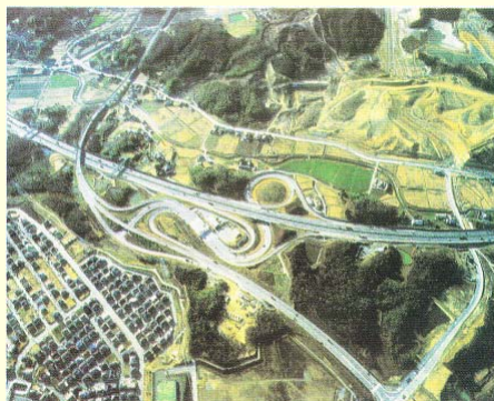
Nút loa kèn xử lý rất tốt trong điều kiện địa hình khó
