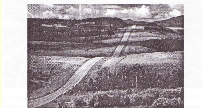
Hình 3.46. Dồi dốc và bố trí đường cong đứng phù hợp với địa hình
