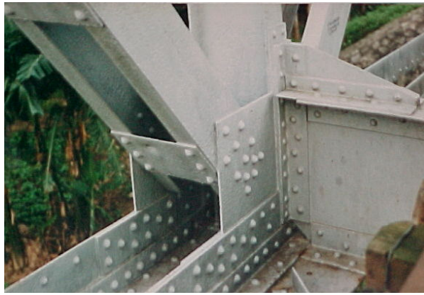
Hình 4.16. Cấu tạo nút giàn cầu thép
