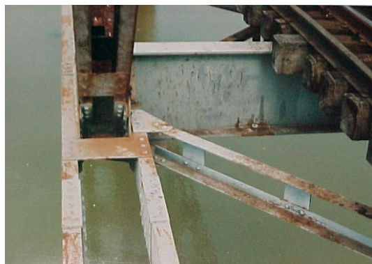
Hình 4.17. Cấu tạo nút giàn có các thanh gắn trực tiếp vào nhau
