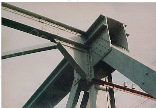
Hình 4.19. Cấu tạo một nút giàn có bản nút riêng rẽ
