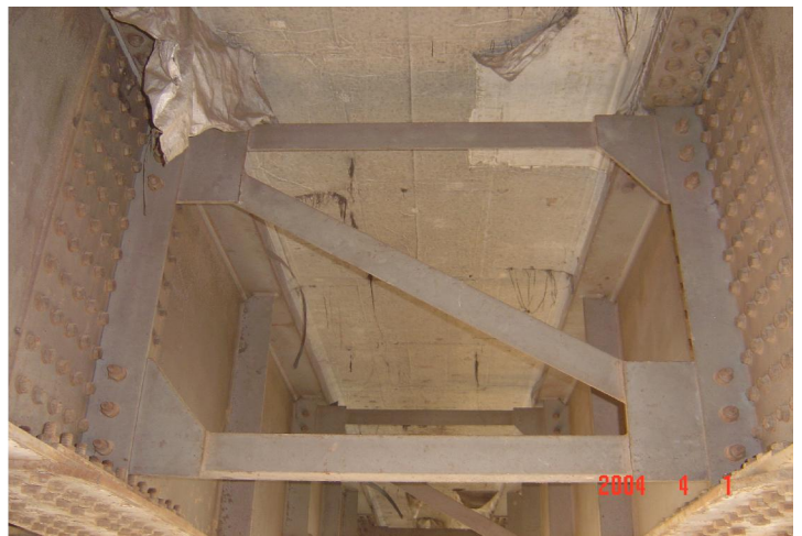
Hình 2.48: Hệ liên kết ngang cầu.
