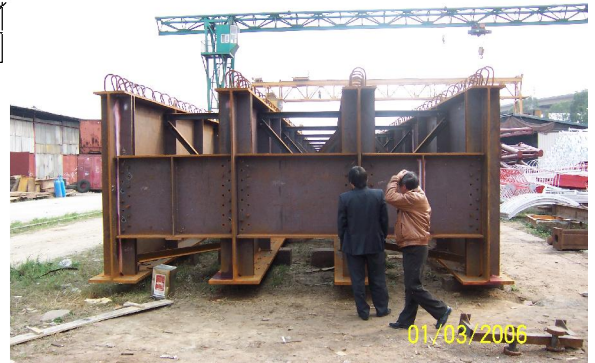
Hình 2.50: Dầm ngang tại gối.
