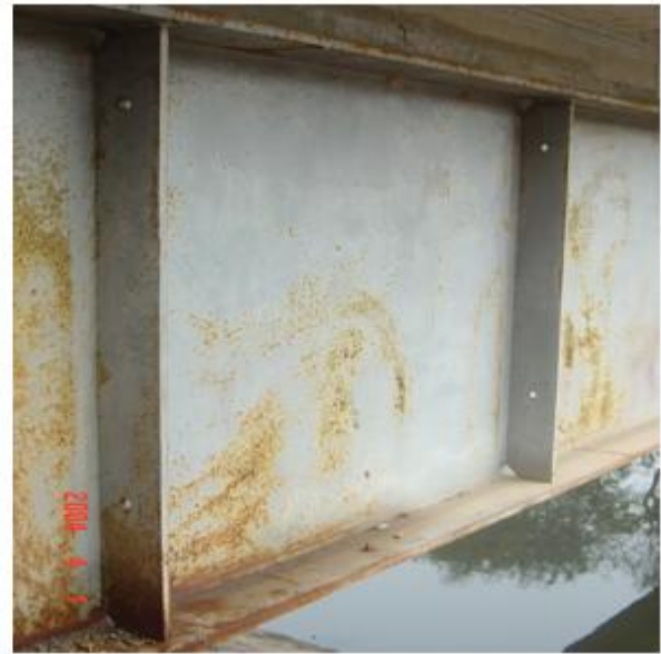
Hình 2.45b: Sườn tăng cường trung gian.
