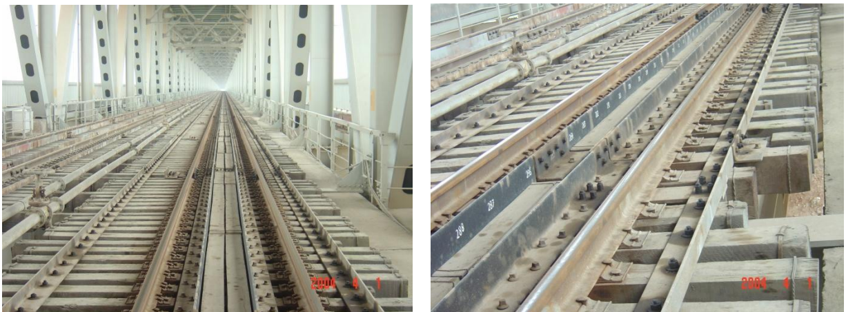
Hình 2.14b: Mặt cầu trần có tà vẹt đặt trực tiếp lên dầm.
