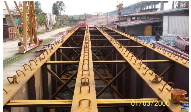
Hình 2.52: Hệ liên kết ngang tại mặt cắt trung gian.
