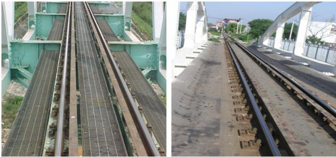
Hình 2.15b: Mặt cầu có ray đặt trực tiếp lên bản mặt cầu.
