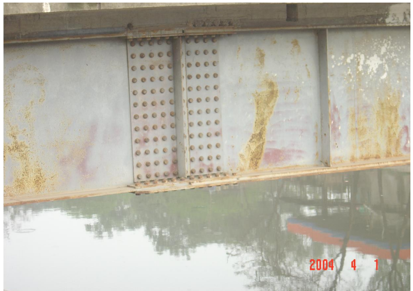
Hình 2.56: Mối nối dầm.
