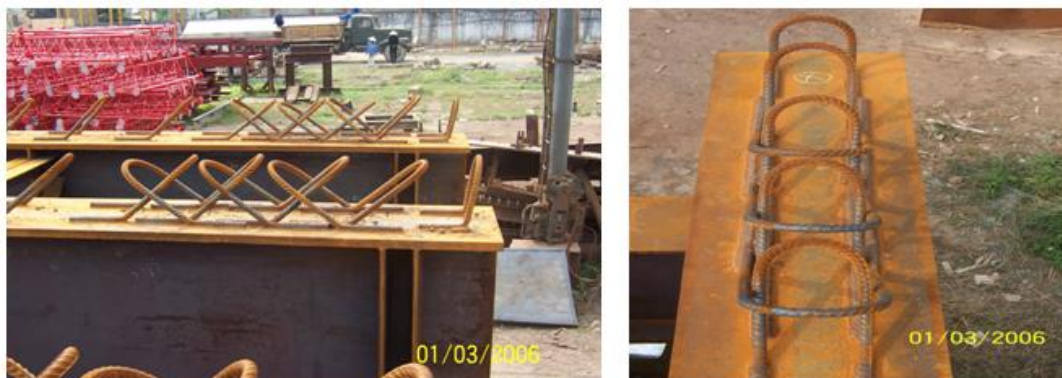
Hình 2.36d: Neo chống trượt do co ngót và thay đổi nhiệt độ.
