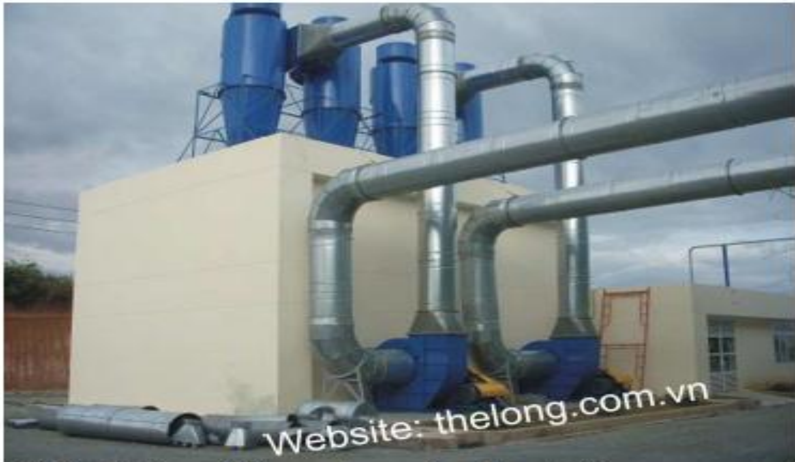
Hình: Ghép nhiều cyclone đơn hoạt động song song
