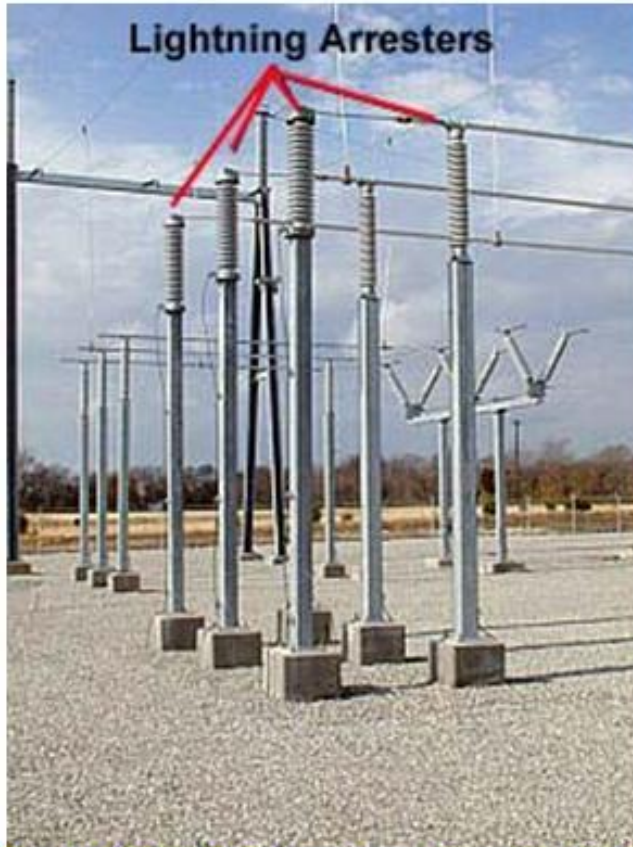
Thiết bị chống sét cho trạm phân phối
