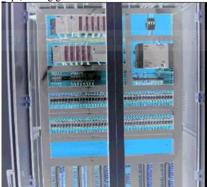
Hình 8.3: Mô hình của tủ điện có lắp đặt PLC
