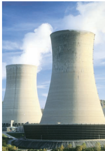
Hình 1.23: Lò phản ứng hạt nhân có tháp làm lạnh với hình dạng Hyperboloid một tầng
