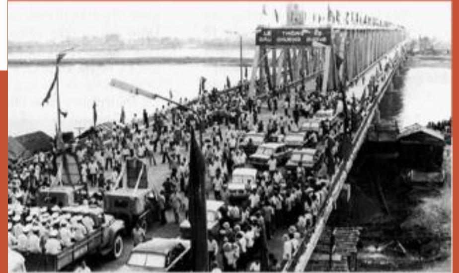
Cầu Chương Dương - Cây cầu tự lực tự cường: Khai công ngày 10/10/1983, thông xe ngày 30/6/1985, cầu Chương Dương bắc qua sông Hồng tại Hà Nội là cây cầu đầu tiên do người Việt Nam thiết kế, thi công, khai thông huyết mạch giao thông góp phần phát triển kinh tế, xã hội. Nguồn: Báo Công An số 40/1985
